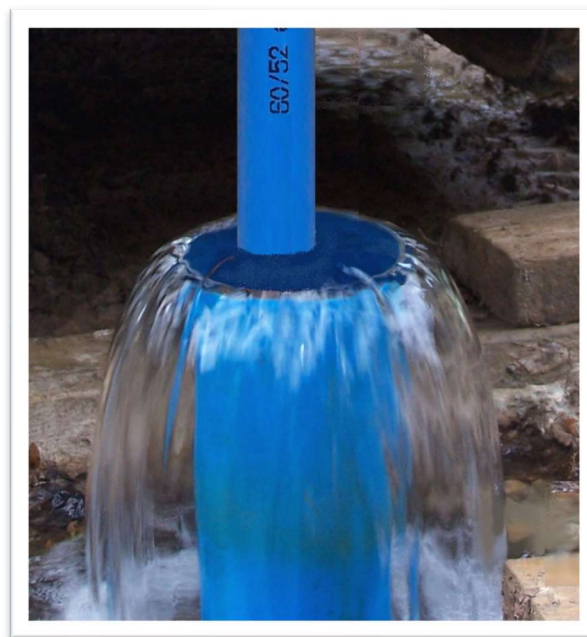
Forage artésien jaillissant – Pose d'un obturateur
