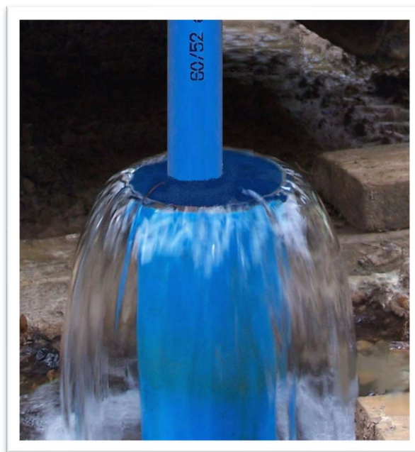
Forage arthésien jaillissant – Pose d'un obturateur
